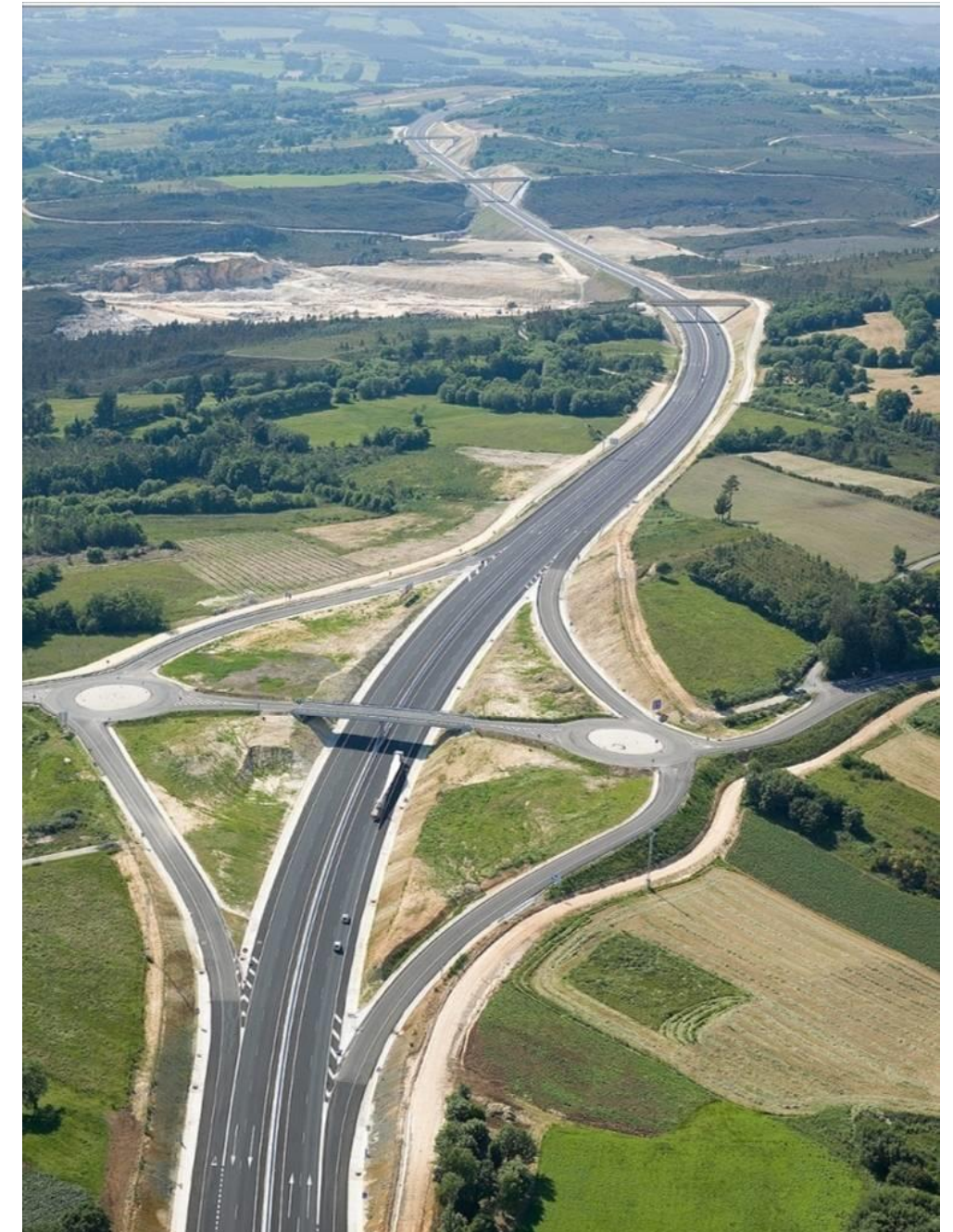
Imagen: Autovía Ferrol-Vilalba. Tramo Cabreiros – Vilalba (puesto en servicio en Febrero de 2010)
